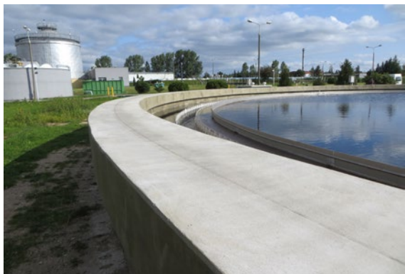
Nowe torowisko osadnika nr 4 na oczyszczalni ścieków fot. Przedsiębiorstwo Wodociągów i Kanalizacji w Suwałkach, fot. archiwum Przedsiębiorstwa Wodociągów i Kanalizacji w Suwałkach Sp. z o.o.
