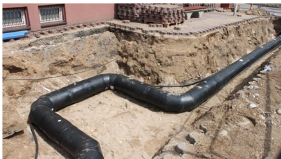
Budowa sieci ciepłowniczej, fot. archiwum PEC w Suwałkach Sp. z o.o.
