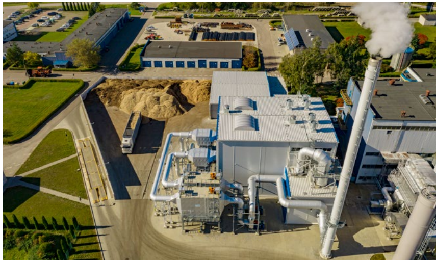
Widok ciepłowni z góry, fot. archiwum PEC w Suwałkach Sp. z o.o
