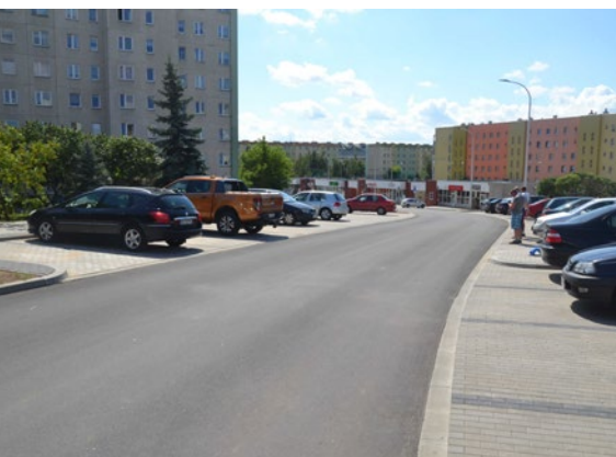
Przebudowa ul. Ludwika Michała Paca w Suwałkach, fot. z archiwum Urzędu Miejskiego w Suwałkach.
