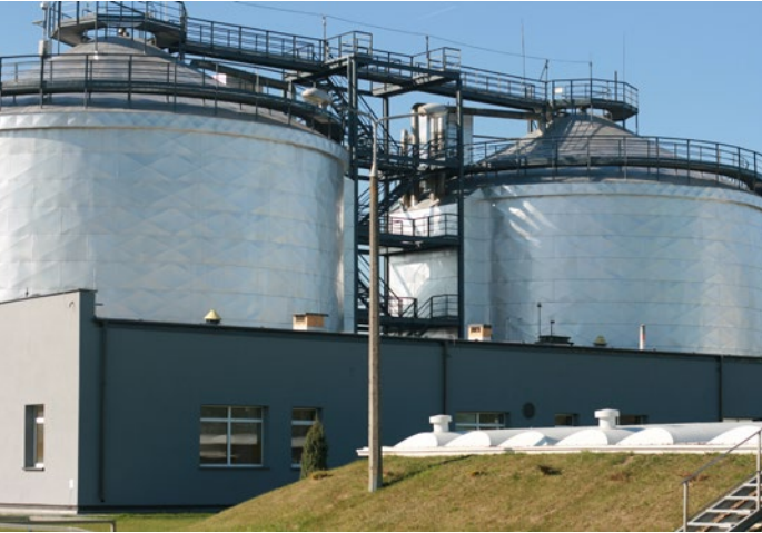
Termomodernizacja dwóch komór fermentacyjnych na oczyszczalni fot. Przedsiębiorstwo Wodociągów i Kanalizacji w Suwałkach, fot. archiwum Przedsiębiorstwa Wodociągów i Kanalizacji w Suwałkach Sp. z o.o.
