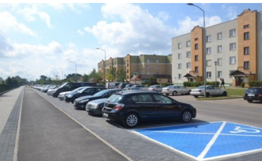
Przebudowa parkingu oraz ciągu pieszo-rowerowego przy ul. Szpitalnej, fot. z archiwum Urzędu Miejskiego w Suwałkach.
